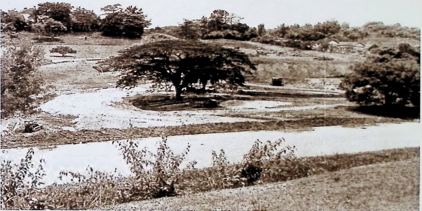
Kawasan berbukit seluas 16.2 hektar yang dahulunya dikenali sebagai 'West Folly Hill' sedang diratakan bagi kerja-kerja awal pembinaan Kompleks Bangunan Parlimen 1961
