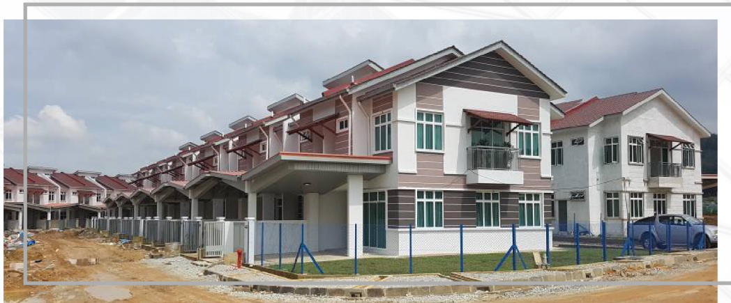
Perumahan Sungai Bakap Fasa 1 (rumah teres dua tingkat) dalam pembinaan
