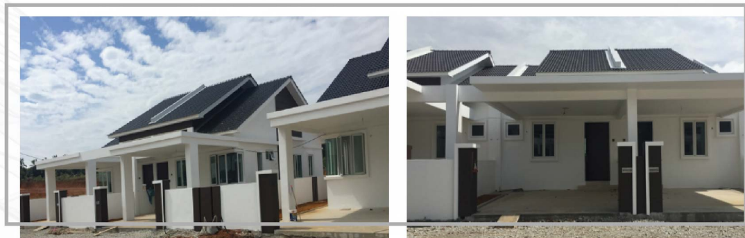
Projek Pembangunan Taman Desa Ara Permai dalam pelaksanaan
