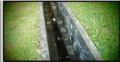
Sistem saliran dengan kapasiti yang tidak mencukupi
