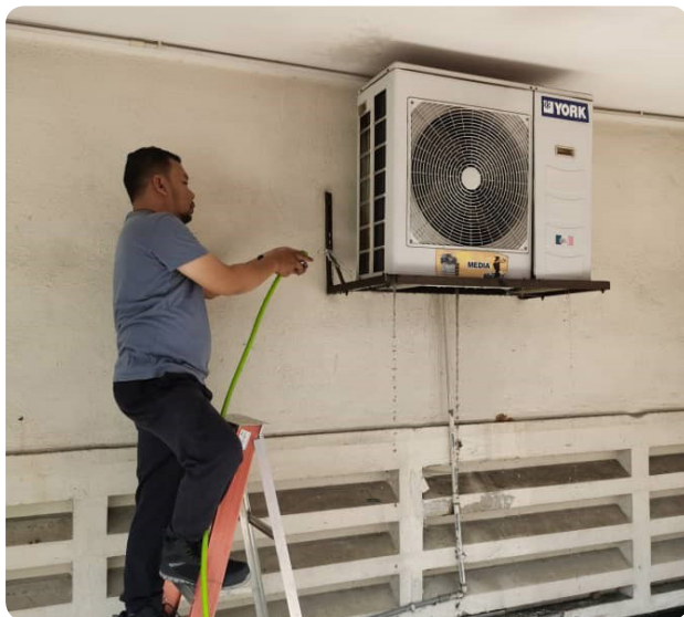
Kerja-kerja pembaikan penyaman udara di bangunan asrama FINAS Hulu Kelang
