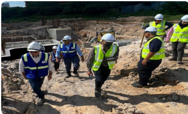
Pemeriksaan projek dan mesyuarat gerak kerja bulanan di tapak projek FINAS Damansara
