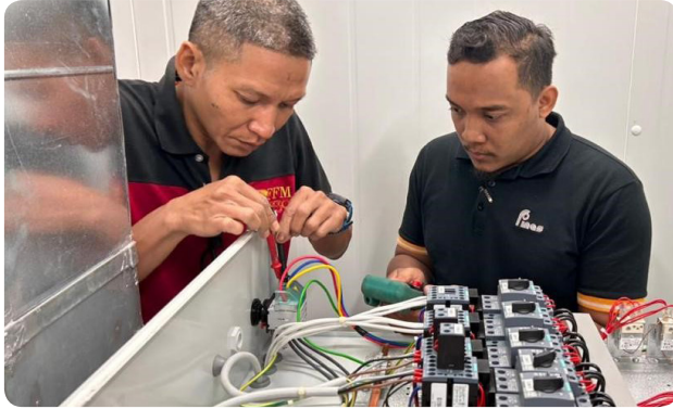
Kerja-kerja troubleshoot sistem dehumidifier di film vault FINAS Petaling Jaya.
