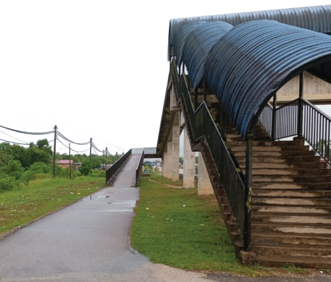
Jejantas kombinasi tanjakan dan tangga tetapi dibina berasingan tempat naik untuk motosikal (ramp) dan pejalan kaki (tangga). A combination of overhead bridge with ramp and stairs but built separately for motorcycles (ramps) and pedestrians (stairs).
