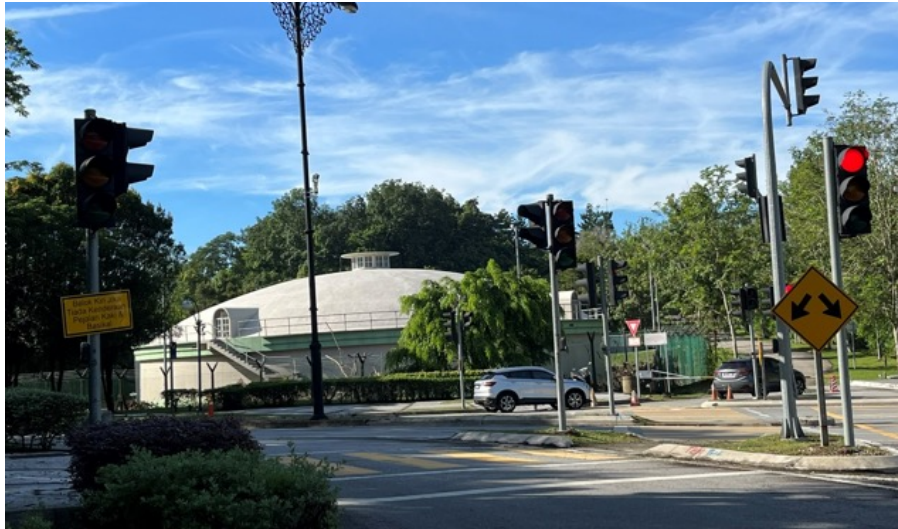
Lampu isyarat yang tidak beroperasi. Non-operated traffic light.
