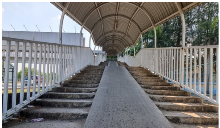
Jejantas motosikal jenis ramp yang khusus untuk penggunaan motosikal sahaja. Overhead motorcycle bridge with ramp type that is specifically for motorcycles used only.
