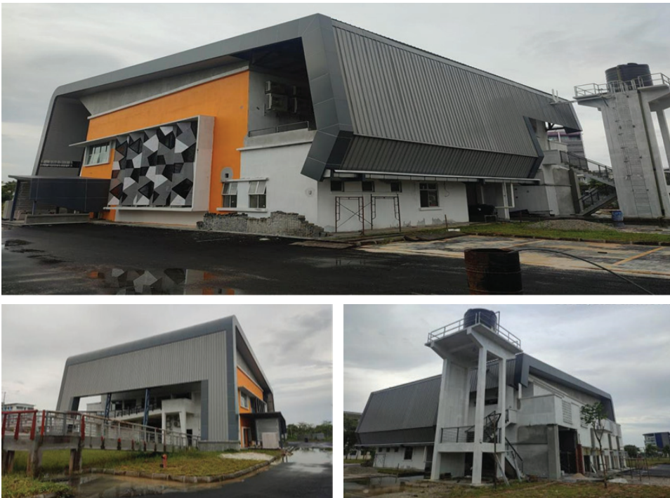
Foto 8.3 : Pembangunan Pusat Data baharu dan perolehan peralatan
