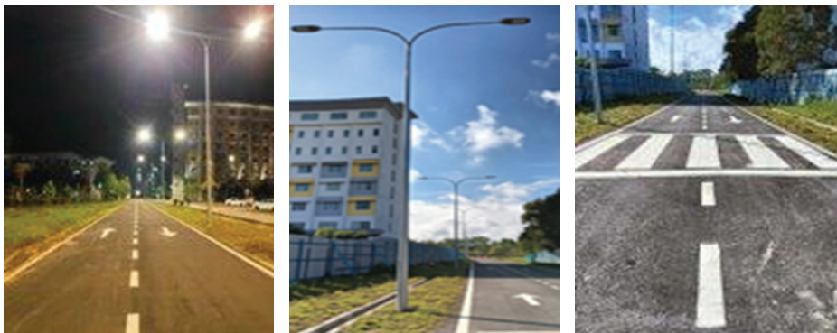
Foto 8.6 : Pembinaan jalan masuk serta kerja-kerja berkaitan bagi Pusat Data baharu dan perolehan di UTHM
