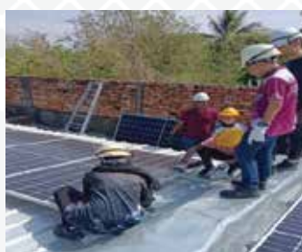
Latihan praktikal pemasangan solar panel di atas bumbung sebenar
