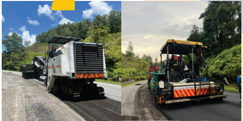
Rajah 10: Kerja-kerja penurapan jalan menggunakan CMB di Jalan Pengkalan Hulu – Baling, Daerah Baling, Kedah
