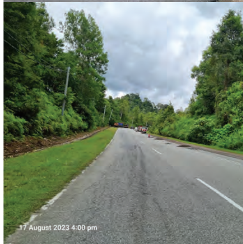
Rajah 11: Keadaan permukaan jalan sebelum dan selepas turapan menggunakan CMB di Jalan Pengkalan Hulu - Baling, Daerah Baling, Kedah
