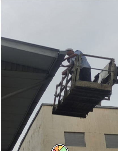
Kerja-kerja pemasangan gutter yang baru di Bangunan Film Vault serta memasang lapisan zink/ flushing di Bangunan Utama Aras 3 di FINAS Petaling Jaya.
