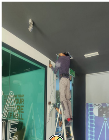
Kerja-kerja pendawaian baharu serta penyediaan mainhole untuk penyaman udara di Mediatheque.
