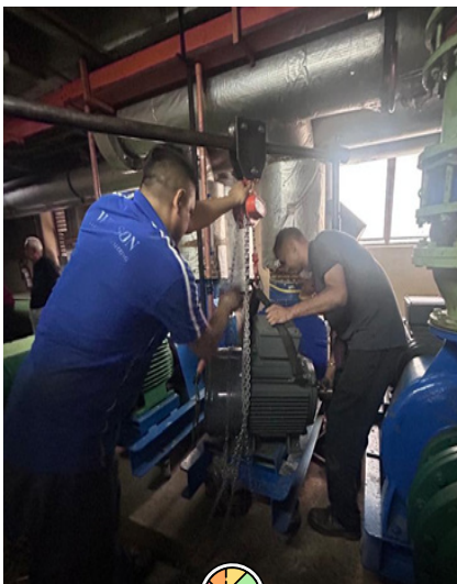
Kerja-kerja pembaikan sistem chiller FINAS Petaling Jaya.
