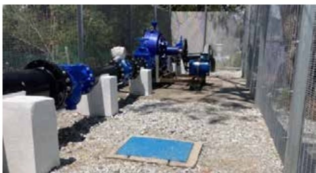
SB yang dipasang di Puchong, Selangor telah menghasilkan 420,000 kWh setahun dan menjimatkan kira-kira 327 tan karbon dioksida setiap tahun.
