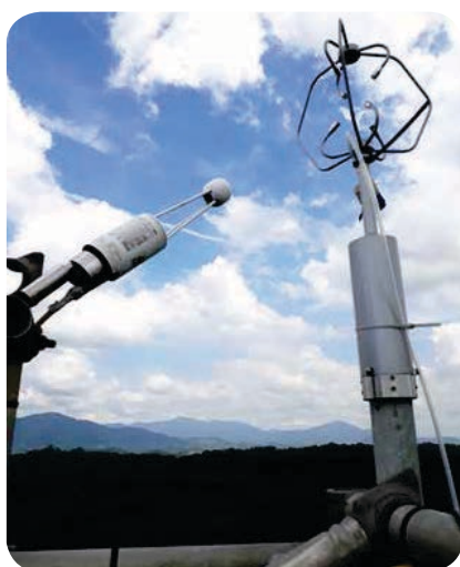
Pemasangan sensor pada menara Flux 52 m untuk mencerap data meteorologi Sensors installed at the 52-m Flux tower to capture meteorological data
