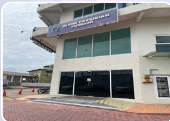
▲ JALAN KEBUN KLANG
