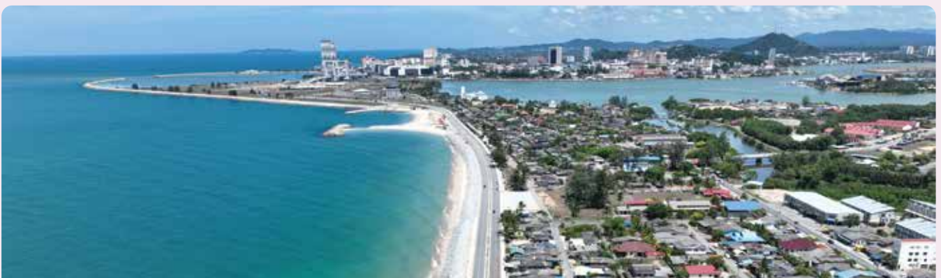
Penambahbaikan Jalan Lapangan Terbang-Kuala Terengganu City Centre, Kuala Terengganu
