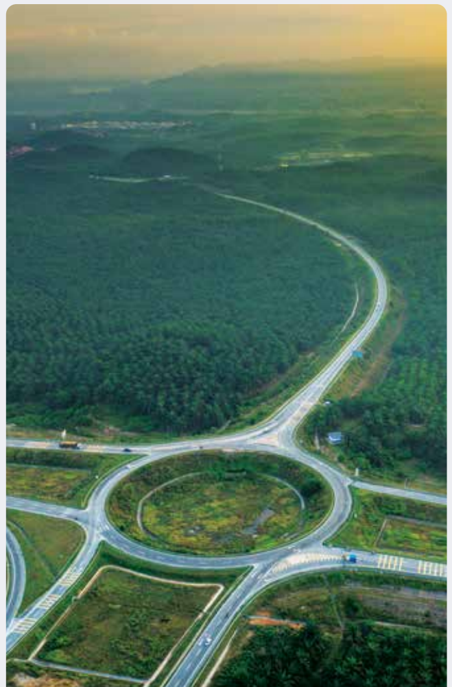
Pandangan udara Jalan Lingkaran Tengah Utama di Bentong, Pahang
