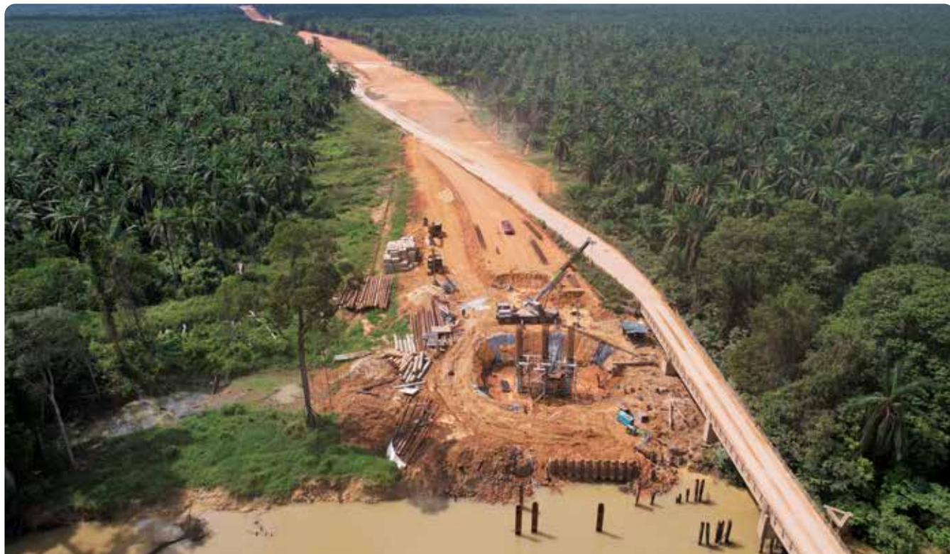
Pembangunan jalan masuk ke Taman Negara Johor Endau-Rompin (TNJER) dari Kahang ke Sungai Emas
