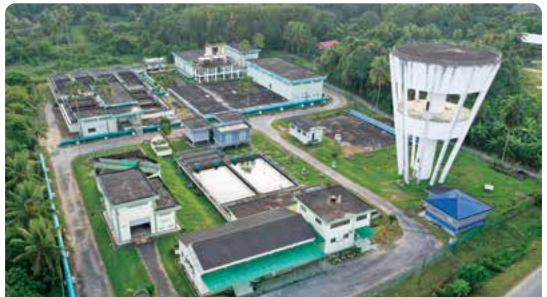
Loji Rawatan Air Kelar (Fasa 1) di Pasir Mas, Kelantan
