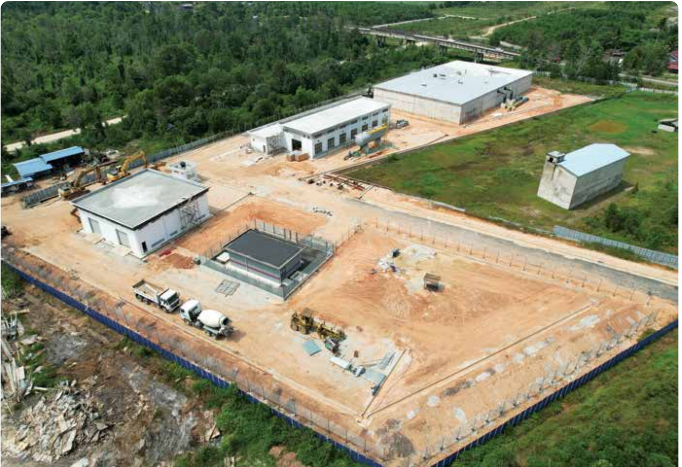
Pembangunan projek Bekalan Air Kemaman-Gebeng
