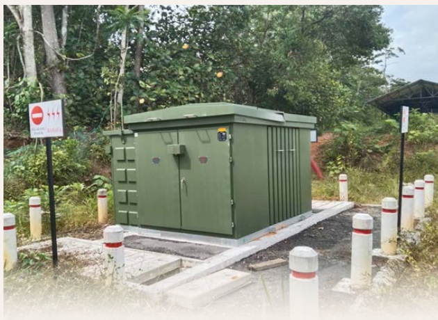
Pemasangan kemudahan elektrik.
